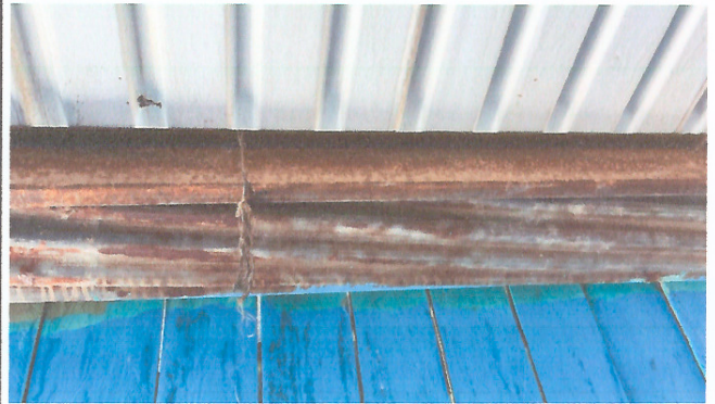
Foto 2: Estructura de Techo
