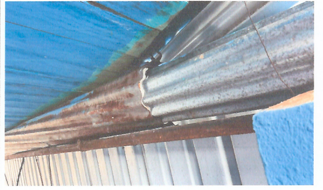
Foto 4: Canales y bajadas de agua.
